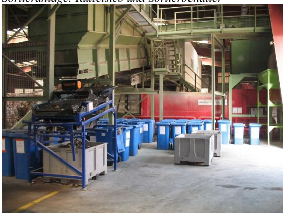
Bild 13: Sortieranlage: Rüttelsieb und Sortierbehälter
