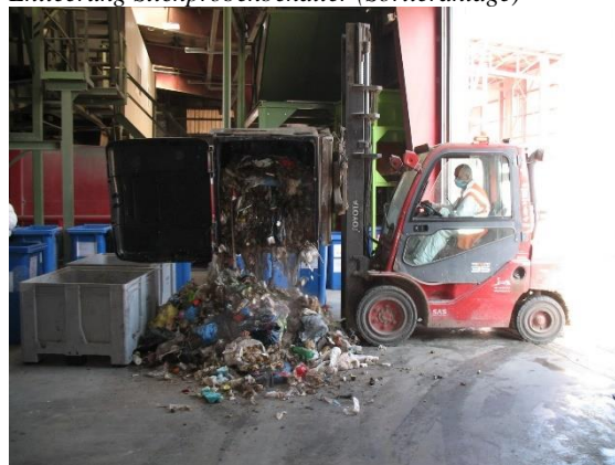
Bild 4: Entleerung Stichprobenbehälter (Sortieranlage)
