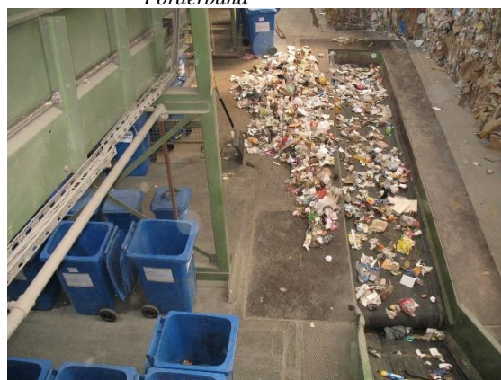
Bild 10: Sortieranlage: Siebüberlauf > 40mm, Rinne und Förderband
