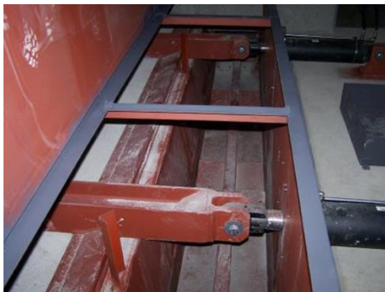
Hydraulischer Direkteinschub, Quelle: E&I Energie und Innovation Ingenieurbüro
